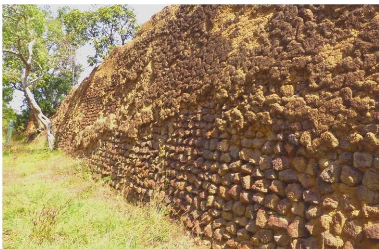
Fig. 1 – Enceinte de Loropéni – Mur ouest, côté externe, montrant des restes de crépi.
