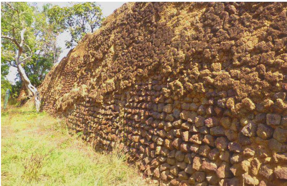
Fig. 1 – Enceinte de Loropéni – Mur ouest, côté externe, montrant des restes de crépi.
