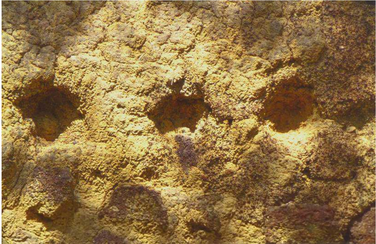
Fig. 3 – Enceinte de Loropéni – Traces de poutres sur mur nord, côté interne.
