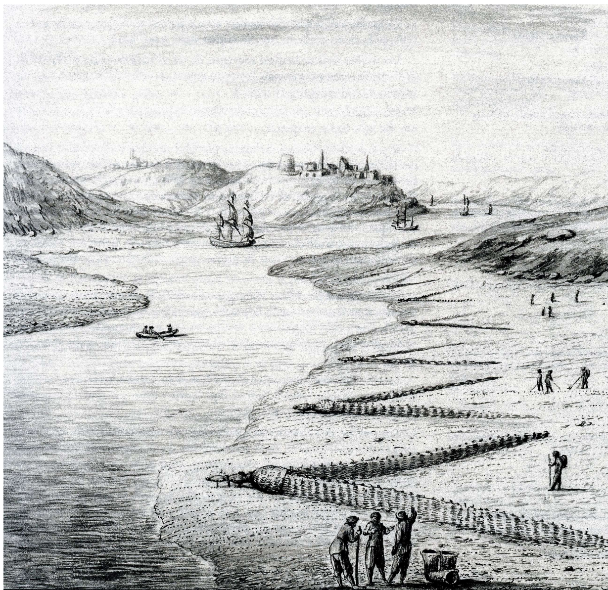
Fig. 2 – Figure de Le Masson du Parc (2004) : description de nassons ou petites gorres avec nasses clayes ou panniens. Ces écluses ressemblent à celle de Cherrueix (35) en baie du Mont-Saint-Michel ou de Blainville (50).
